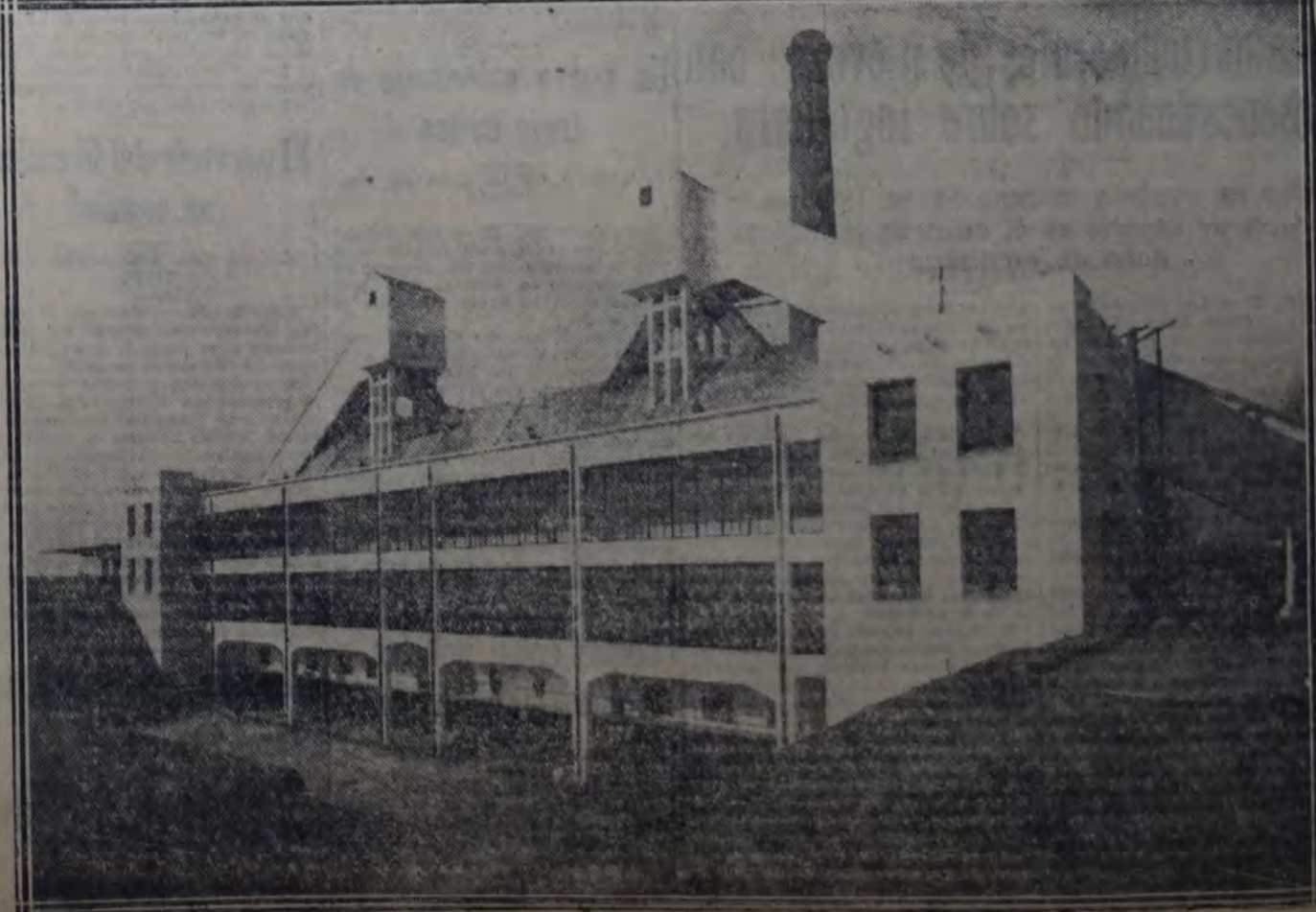
UNA DE LAS FACHADAS EXTERIORES DE LA USINA.
